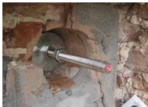
Einbaubeispiel des Spannkraftreglers
