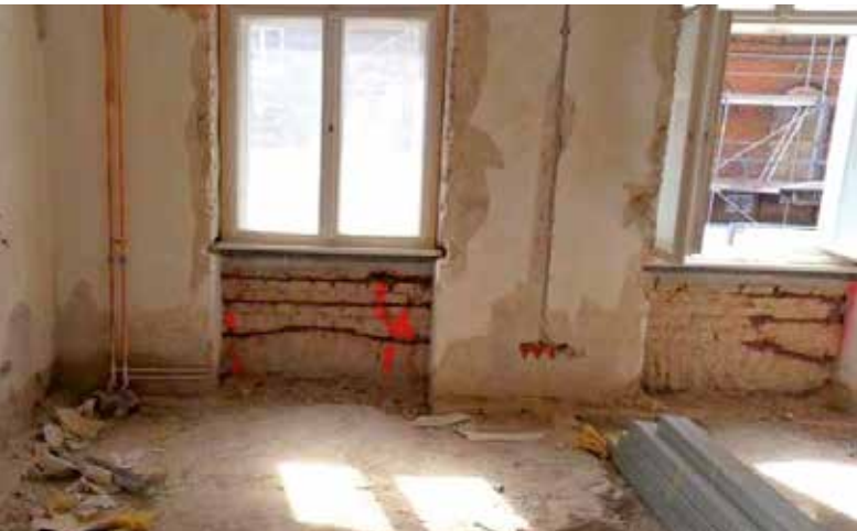
Erste Vorbereitungen zur Sanierung sind getroffen: die vertikalen Schlitzze zur Aufnahme der Spiralanker
