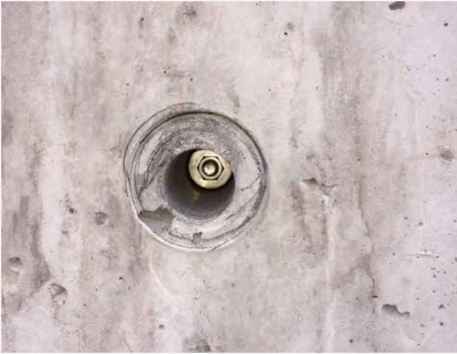
Anwendungsbeispiel: Abdichten des Bohrloches nach Einbringen eines Ankers / Example of use: Sealing of the borehole after insertion of an anchor
