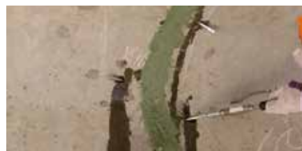
Stahlpacker mit Kegelnippel Steel packer with round head nipple
