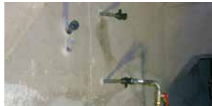
Stahlpacker mit Verschlussstück Steel packer with shut-off piece
