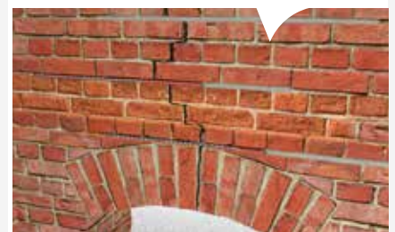
RISSINSTANDSETZUNG MIT DEM DESOI SPIRALANKERSYSTEM
