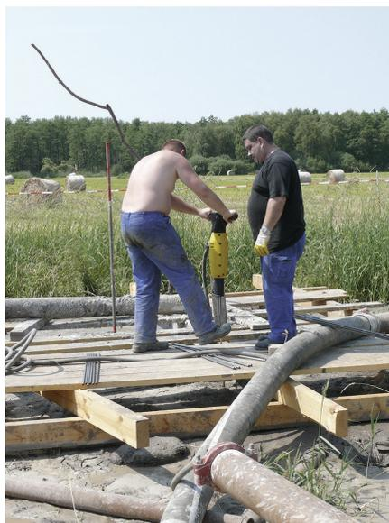
Bild 3: Einbringen der Rammverpressplanzen mit dem Rammhammer (Fotos: Desoi)
