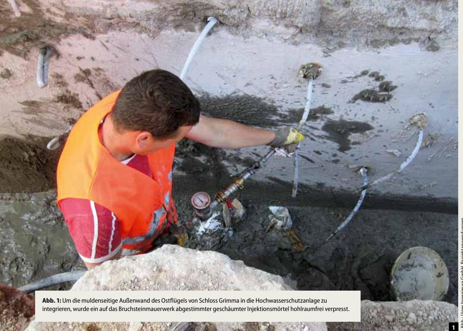
**Abb. 1:** Um die muldenseitige Außenwand des Ostflügels von Schloss Grimma in die Hochwasserschutzanlage zu integrieren, wurde ein auf das Bruchsteinmauerwerk abgestimmter geschäumter Injektionsmörtel hohlraumfrei verpresst.
