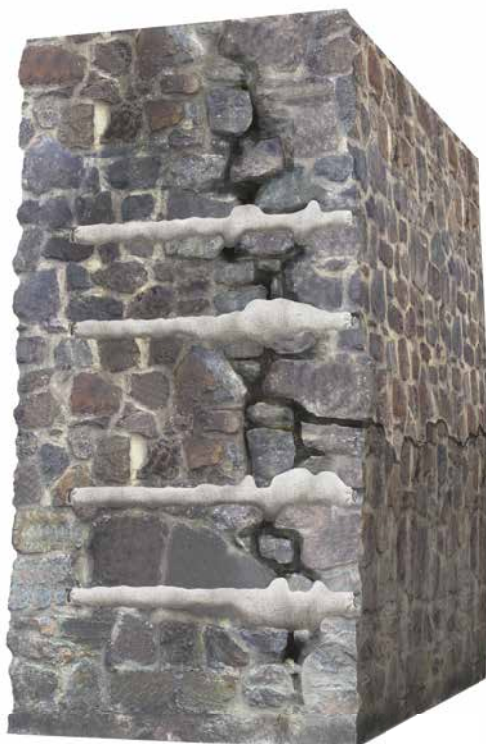
Abb. 4 Anbindung abgelöster Mauerwerkschalen
