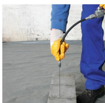
**Rissinjektion mit der Verpressnadel**
