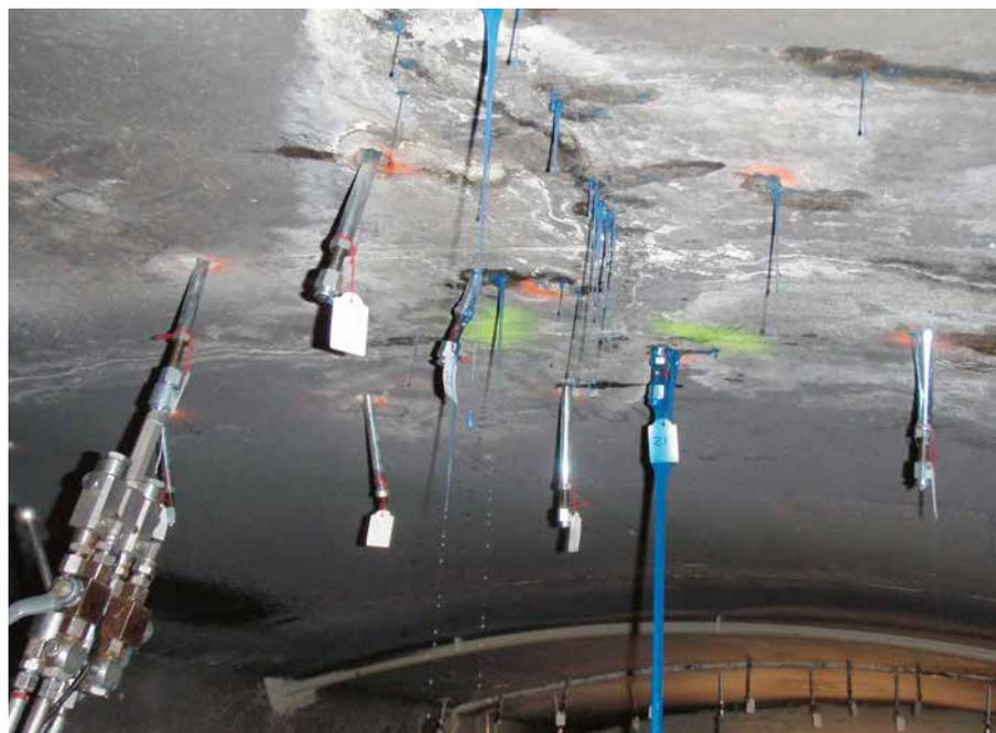
Während des Injektionsprozesses: Anreagiertes Injektionsmaterial.
