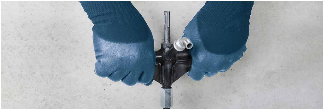
Bei kurzen Längen ist es möglich, die Rammverpresslanzen manuell am Griff zu ziehen. | For short lengths, it is possible to pull the ram injection lances manually by the handle.
