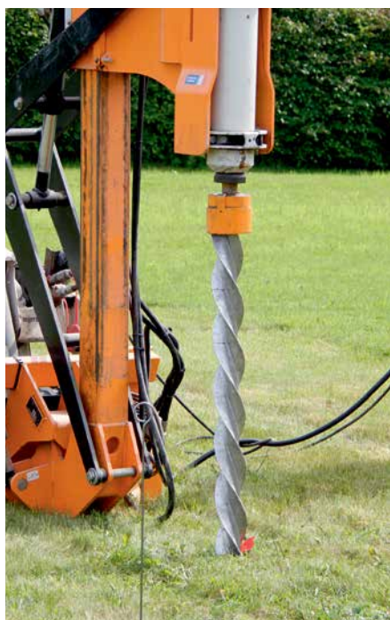
Einrammen der Gewindepfähle Pile-driving
