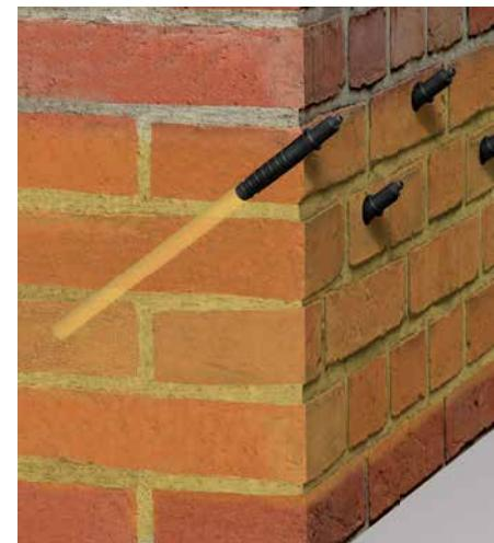
1. Markieren der Bohrlöcher im Abstand von ca. 10 – 12,5 cm bei einer einreihigen Bohrlochkette. Bei mehrreihigen Bohrlochketten ist ein Höhenversatz von ca. 8 cm einzuhalten. Der Bohrlochabstand richtet sich nach der Saugfähigkeit der Baustoffe. Bohrlöcher bohren (mindestens eine Lagerfuge durchstoßen) und Bohrstaub entfernen
