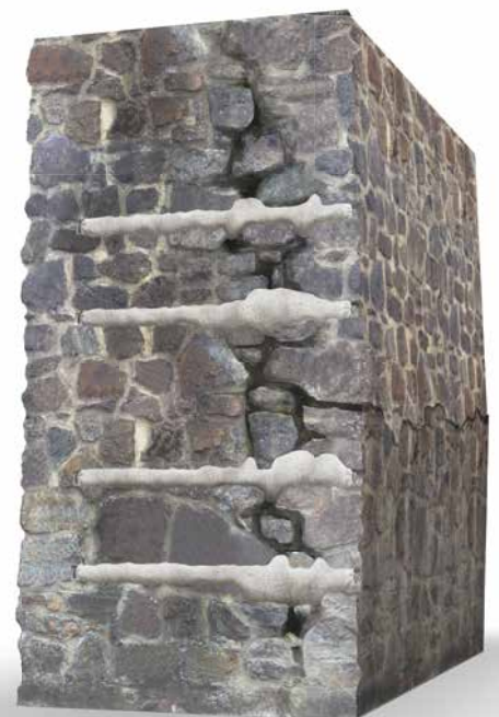
Anbindung abgelöster Mauerwerkschalen Connection of separated wythes
